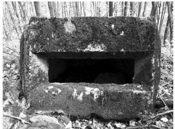
Фото 1. Залізобетонний ковпак з амбразурою зі скосом за вертикаллю (фотографія Максима Ющенка, м. Київ).
