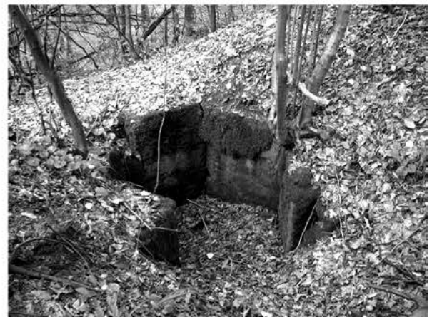
Фото 2. Бетонне кулеметне гніздо в Яблунівському вузлі оборони.
